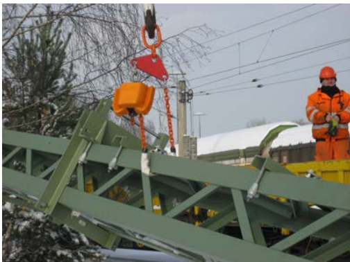
Mast wird gehoben
