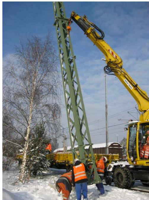
Mast wird auf das Fundament gehoben
