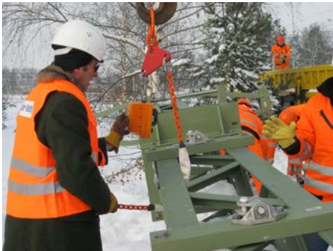
Mast wird angeschlagen
